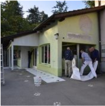
Vorarbeiten beim Eingang....
