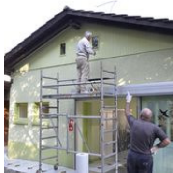
auch ein Gerüst musste gestellt werden
