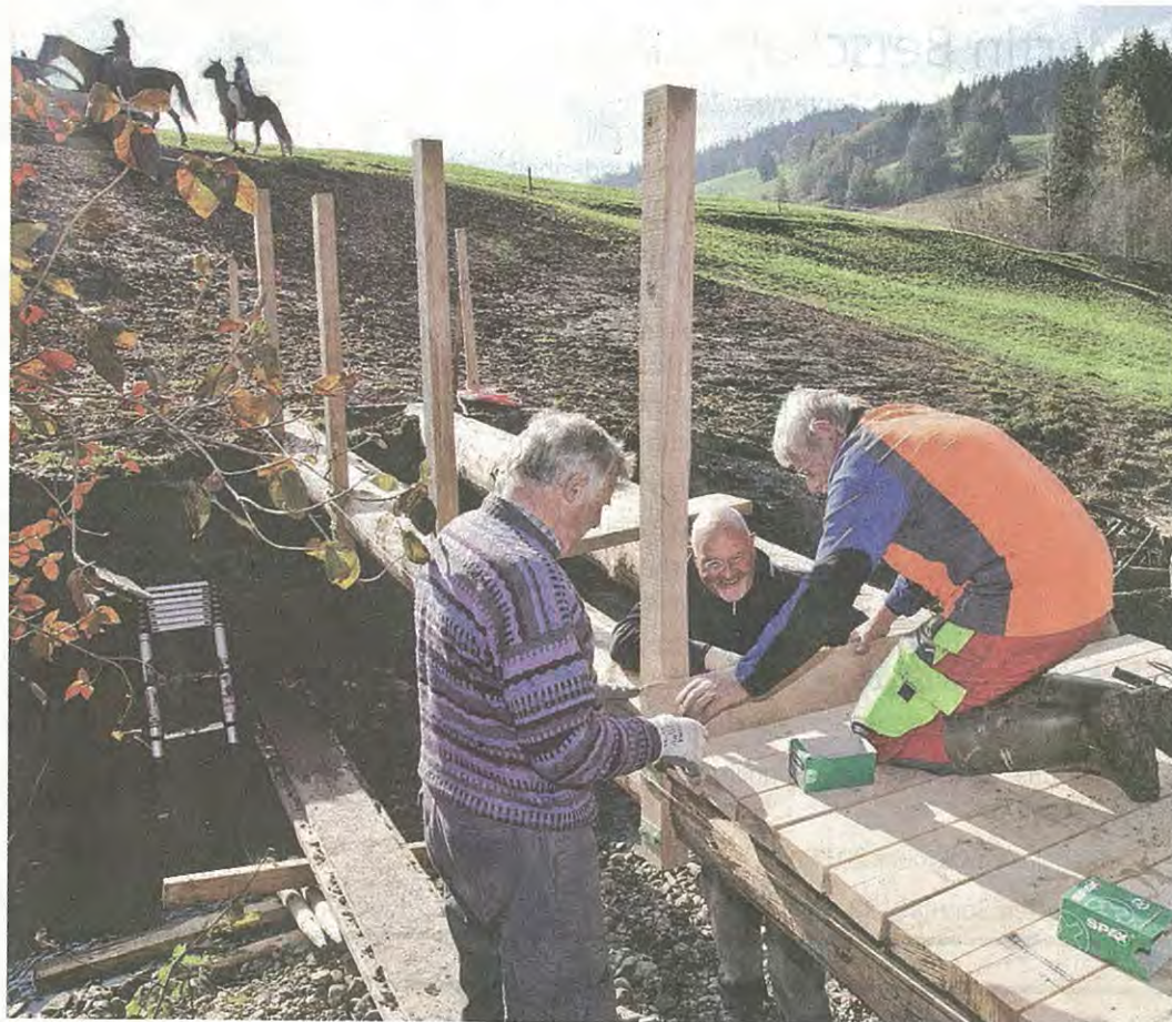
Beim Bibersteg errichteten die Rotarier eine stabile Fussgängerbrücke.
