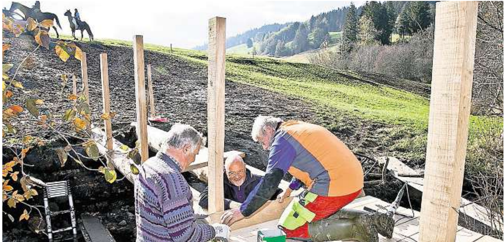
Kraftakt: Beim Bibersteg errichteten die Rotarier eine stabile Fussgängerbrücke.
