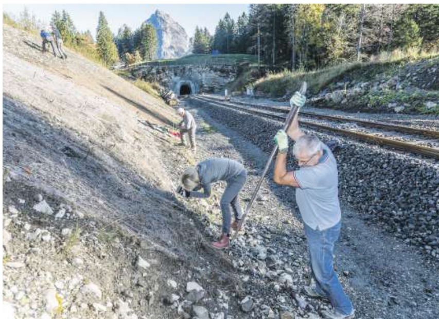
An einem steilen Hang entlang dem neuen Stoosbahntrasseee wurden über 600 Weidenstecklinge gesetzt.
